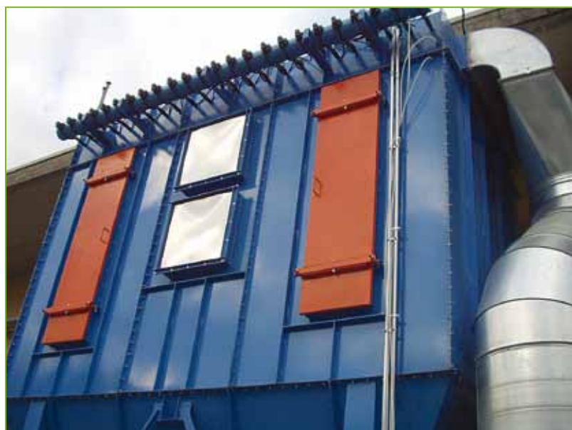
Filtro POLJET a maniche, con dischi di rottura
