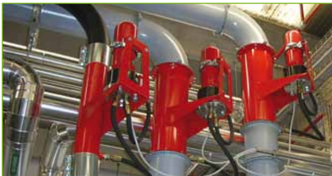
Compartimentazione delle tubazioni
